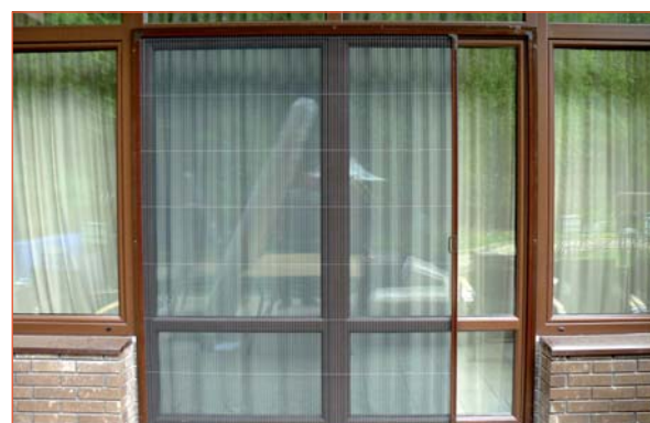
Установка сетки больших размеров
