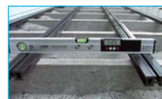
Монтаж на бетонной основе
