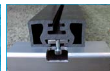
Монтаж на стальной основе
