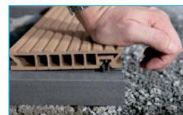
2. Установка первой доски
