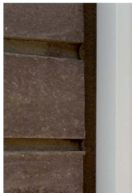
Внешний слой монтажного шва, выполненный с использованием ПСУЛ в соответствии с требованиями ГОСТ
