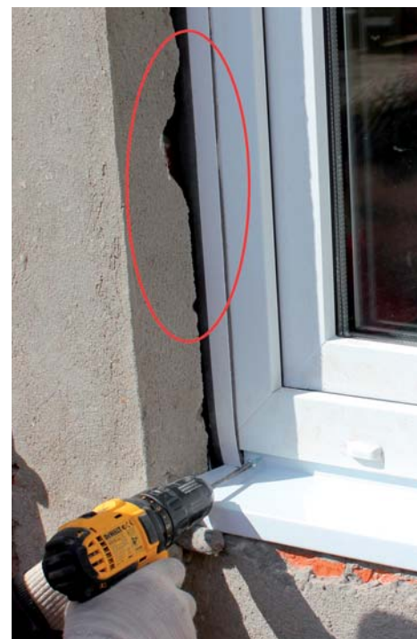
Вид установленной КМП-ленты до внешнего оштукатуривания
