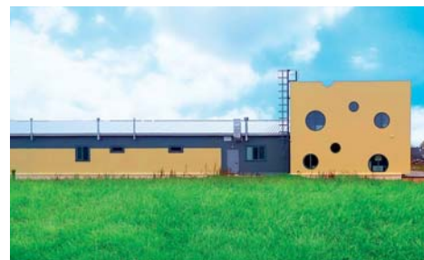
Завод умных окон «Пластком», объект – сыроварня (г. Липин Бор), сайт plastkom.ru
