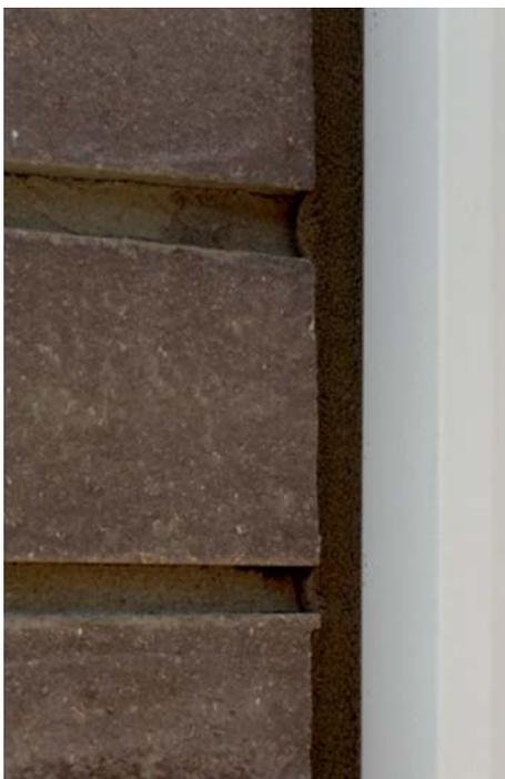
*Внешний слой монтажного шва, выполненный с использованием ПСУЛ в соответствии с требованиями ГОСТ*
