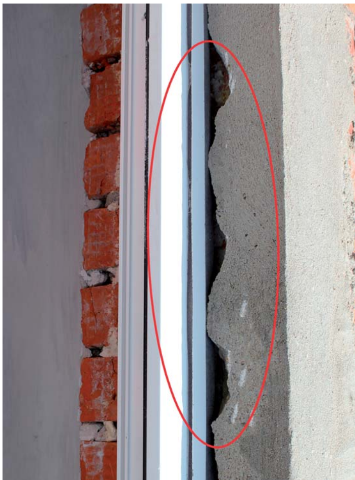
Вид установленной КМП-ленты до внешнего оштукатуривания
