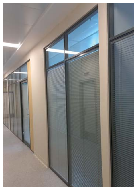
Перегородки в интерьере здания выполнены из легкого металла
