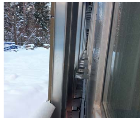
Здание облицовано 3-слойными сэндвич-панелями из алюминия
