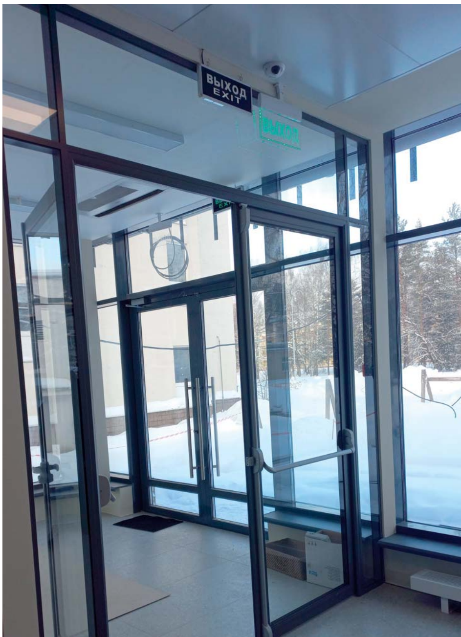
Входные конструкции сделаны из алюминия
