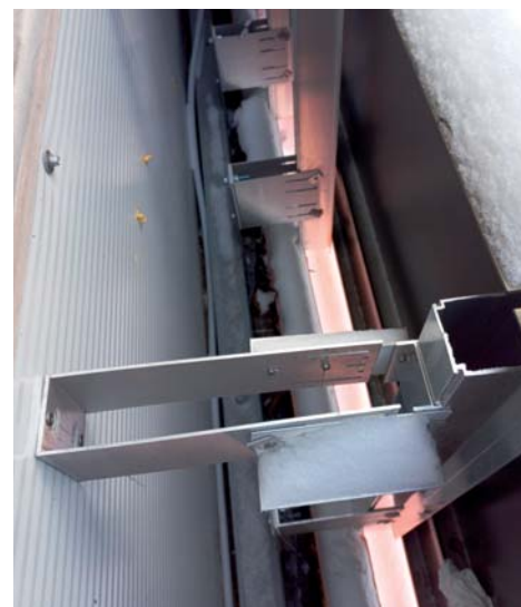
Подсистемы из крылатого металла не боятся перепадов температуры и влажности
