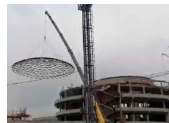
Алюминиевый купол над образовательным центром в г. Когалыме. Разработчик и производитель компания «Несущие системы», г. Новосибирск
