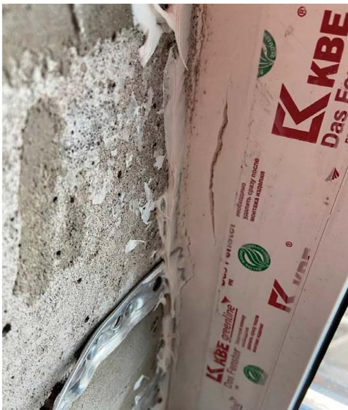
Рис. 1. Фотография герметика с разрывами
