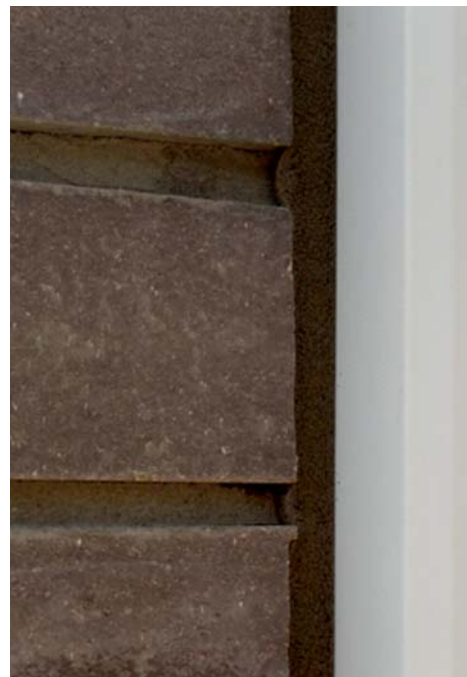
Внешний слой монтажного шва, выполненный с использованием ПСУЛ в соответствии с требованиями ГОСТ
