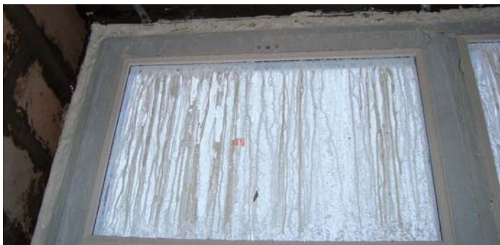
Рис. 1. Пример стекания внутреннего герметика для монтажного шва
